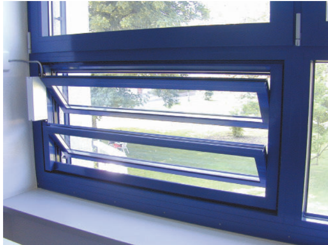
Abbildung 40. Elektrisch verstellbare Kippfenster zur Nachtauskühlung im PC-Pool (halb geöffnet).
